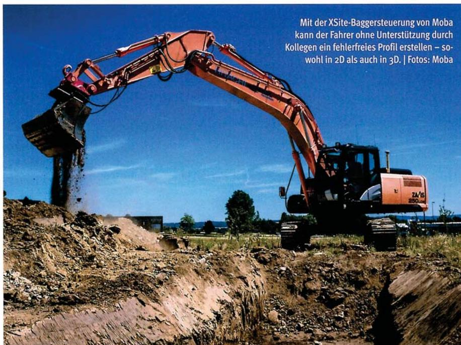
Mit der XSite-Baggersteuerung von Moba kann der Fahrer ohne Unterstützung durch Kollegen ein fehlerfreies Profil erstellen – sowohl in 2D als auch in 3D. | Fotos: Moba
