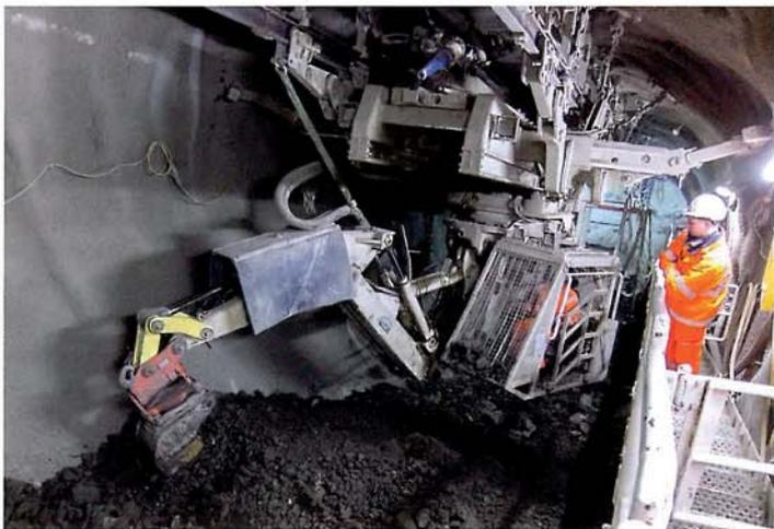
**Von unten nach oben:** Die neuartige Vortriebsmaschine hängt an Tragschienen an der Decke und kann alle für einen konventionellen Tunnelvortrieb notwendigen Arbeitsschritte ausführen. (Foto: BeMo Tunneling)
